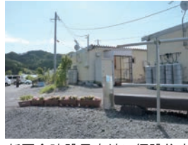
新園舎建設予定地に仮設住宅
