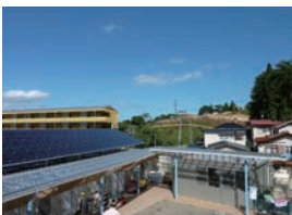
仮園舎の奥の山に新園舎建設予定
