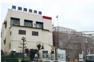
右が現在建設中の新園舎、左が長年慣れ親しんだ既存の園舎。
